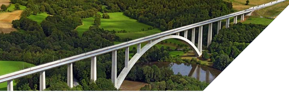
Talbrücke Froschgrundsee (Foto: Nürnberg Luftbild, Hajo Dietz)
